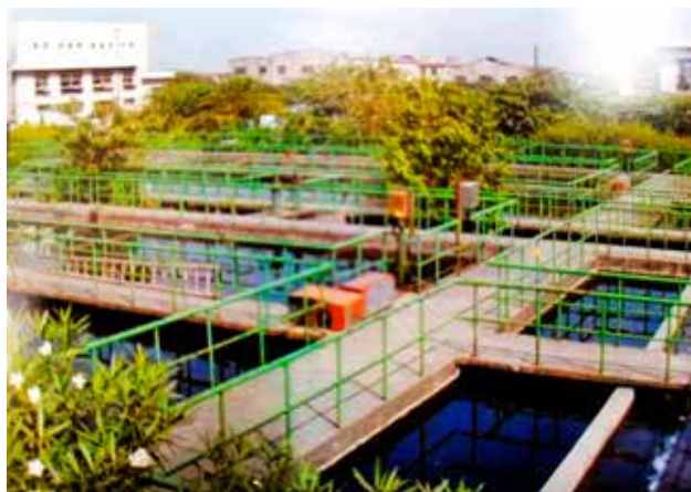
SRL 污水处理厂一角
